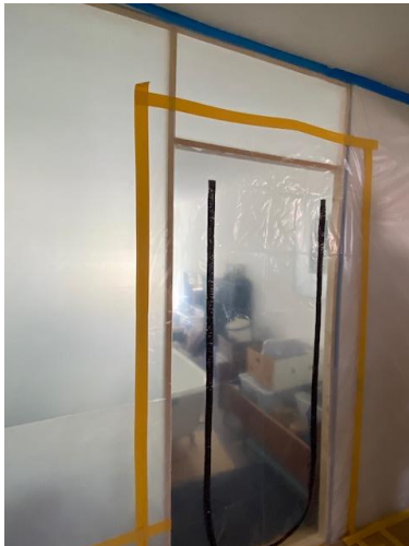
Bild 2: Dragkedjesluss i dörr
